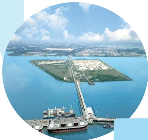
Pelabuhan laut dalam berkapasitas 10 juta ton kargo (Fase 1) curah dengan rencana pengembangan untuk memperluas kapasitas untuk melayani barang curah gas, kontainer, dan cair dan kering dengan luas total 400HA dan kedalaman 14-16M
