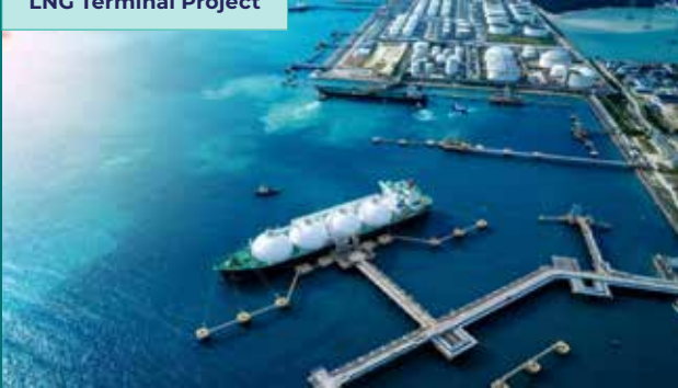
LNG Terminal Project
